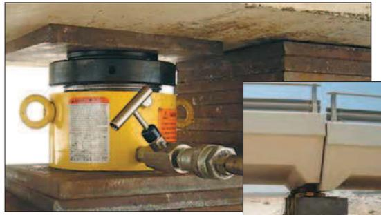
**Плавающие опорные головки**
