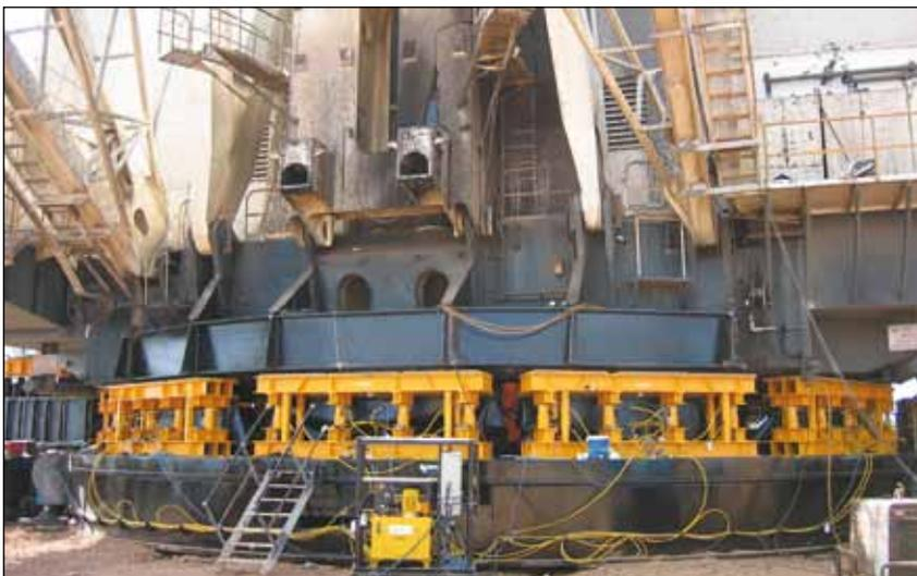
▼ Мост Виадук Мийо, Франция: Система подъема и надвигки моста. Груз уравновешен группами цилиндров серии CLL со стопорной гайкой. Гидравлические системы для подъема, наращивания мостовых секций и балансировки синхронизировались при помощи микропроцессорного управления.
