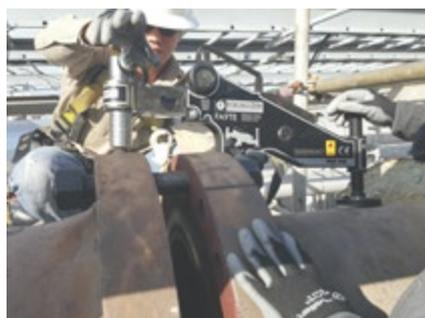
Компания, использующая **Equalizer FA9TE** Гидравлический выравниватель для фланцев на площадке в Техасе
