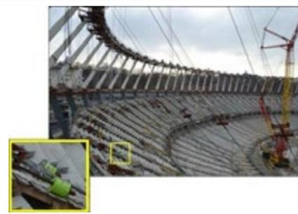
Суммарная грузоподъемность всех цилиндров достигала более **30 000 тонн**.
