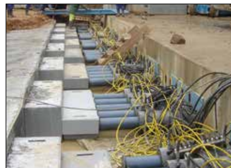
▲ Подъем опор: Синхронные подъемные системы с множеством точек для гидравлического проталкивания секций обделки тоннеля под железнодорожным полотном.
