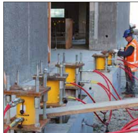
▼ Подъем и выравнивание блоков фундамента здания.
