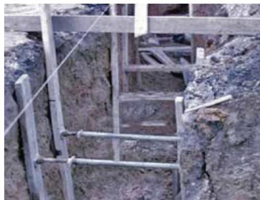
Распорки креплений траншей SIMPLEX серии SE используются для подпорки стенок этой траншеи при ремонте подземного водопровода.
