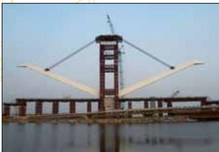
Высокоточный подъем тяжелых конструкций с использованием домкратов
