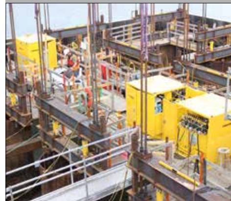
▲ Заказной гидравлический насос для системы надвигки мостов.
