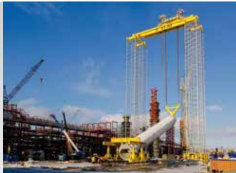
Самомонтируемый подъемник Enerpac представляет собой самосборную подъемную систему, способную самостоятельно смонтировать автономный Гидравлический подъемник кран фактически с уровня земли. Мы предлагаем самомонтируемые подъемники различной грузоподъемности и высоты. Они собираются из стандартных модульных компонентов, что позволяет создавать гибкие решения, легко адаптируемые под потребности будущих проектов.
