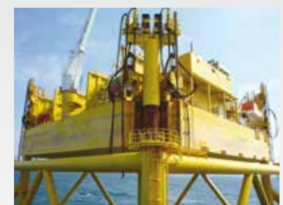
Морская платформа подрядчика, занимающегося подъемом затонувших судов, находилась в неустойчивом состоянии и подвергалась риску разрушения. Компания Enerpac предоставила подрядчику комплексное инженерное решение для подъема платформы в безопасное состояние. После этого компания Enerpac поставила 16 тросовых домкратов и несущие конструкции общим весом 120 тонн, с помощью которых платформу удалось поднять на требуемую высоту и закрепить.
