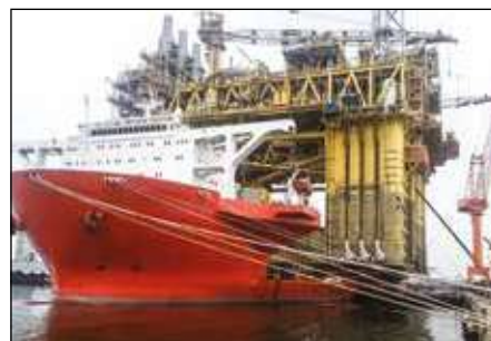
Монтаж и спуск их на воду
