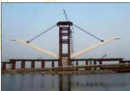
Высокоточный подъем тяжелых конструкций с использованием домкратов
