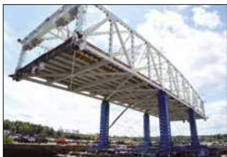
Ступенчатый подъем секций мостов
