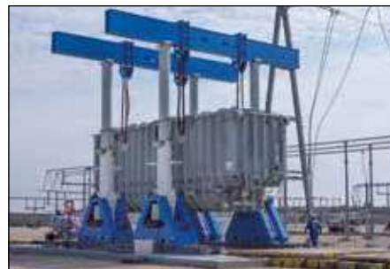
Высокоточный подъем и позиционирование
