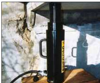
◀ Переносной цилиндр RACL-1506 со стопорной гайкой, используемый для удержания груза во время заливания эпоксидной смолы при укреплении моста.
