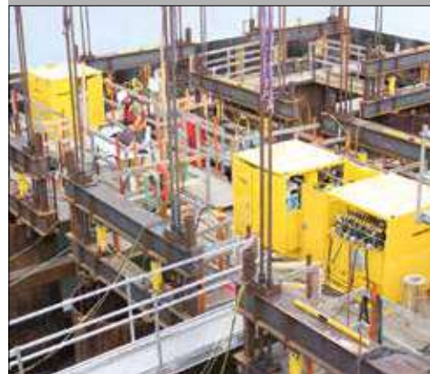
▲ Заказной гидравлический насос для системы надвигки мостов.
