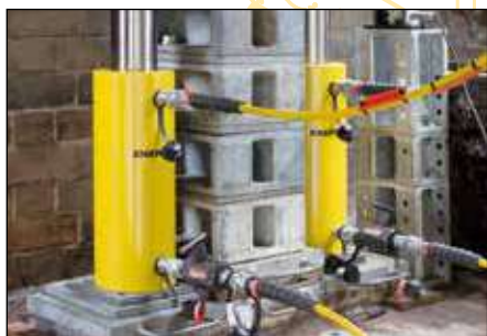
Подъем и надвигка мостов
